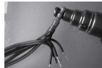
6.6. Проверьте, что термоусадочная часть конусной муфты правильно обжала провода. Нагрейте клейкую массу так, чтобы она начала плавиться и стекать сквозь провода.
